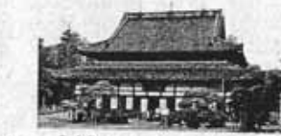
解体工事が始まる「法堂」
